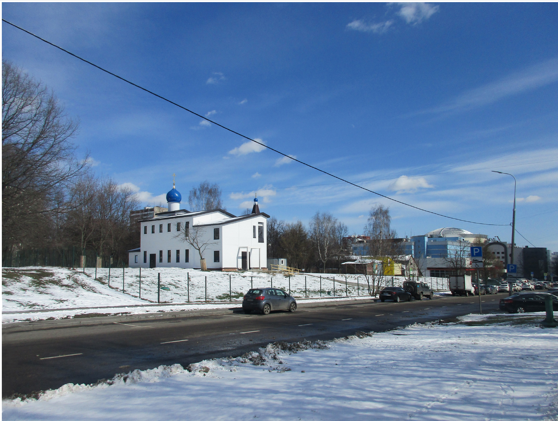
Вид 2 (с юго-запада). Фотофиксация
