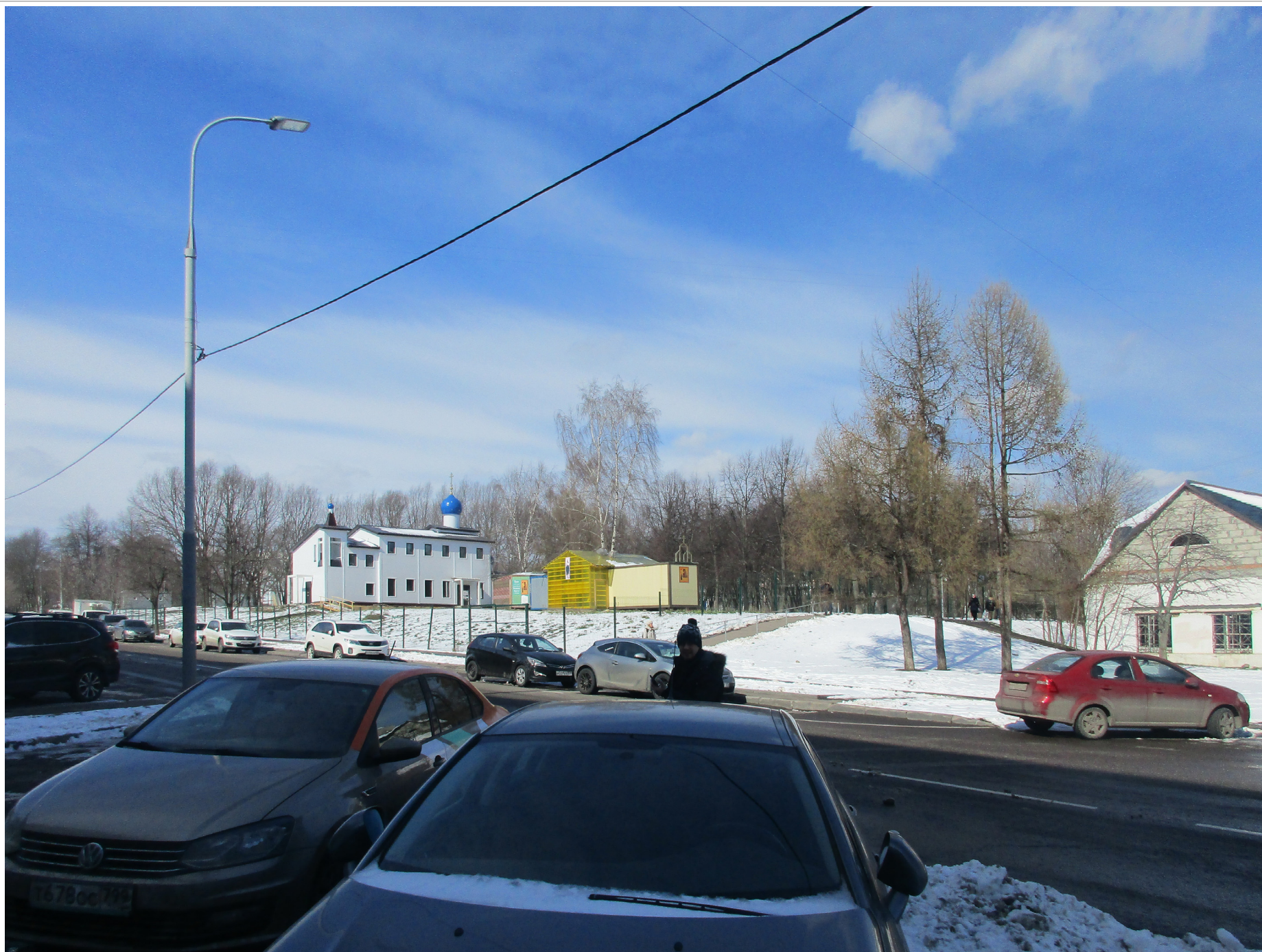
Вид 1 (с юго-востока). Фотофиксация
