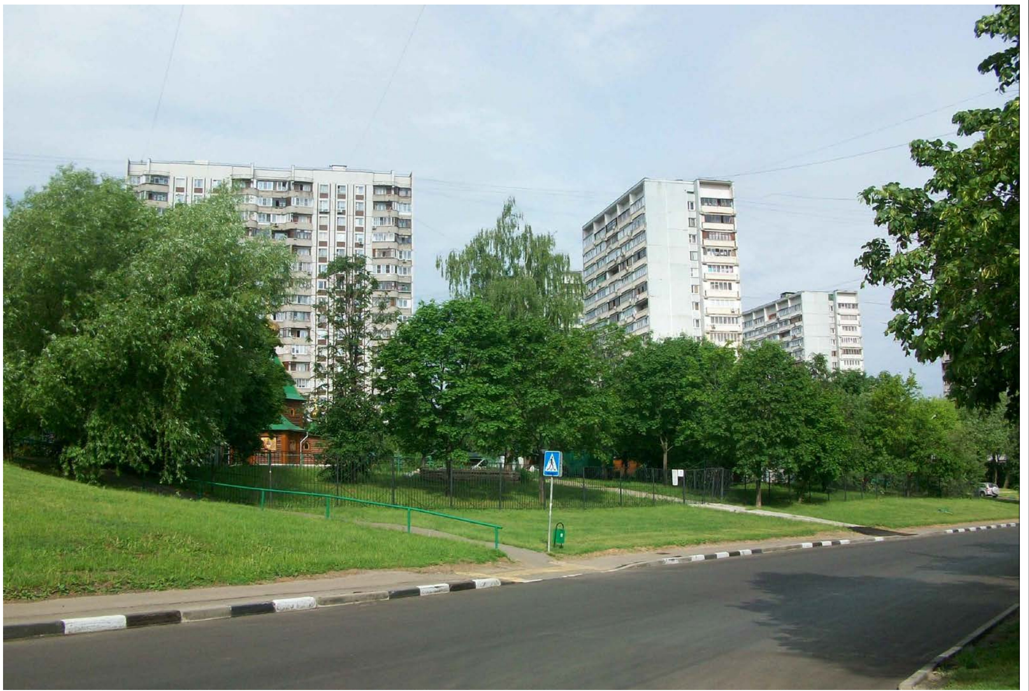
Фотофиксация 1 (со стороны ул. Днепропетровская)
